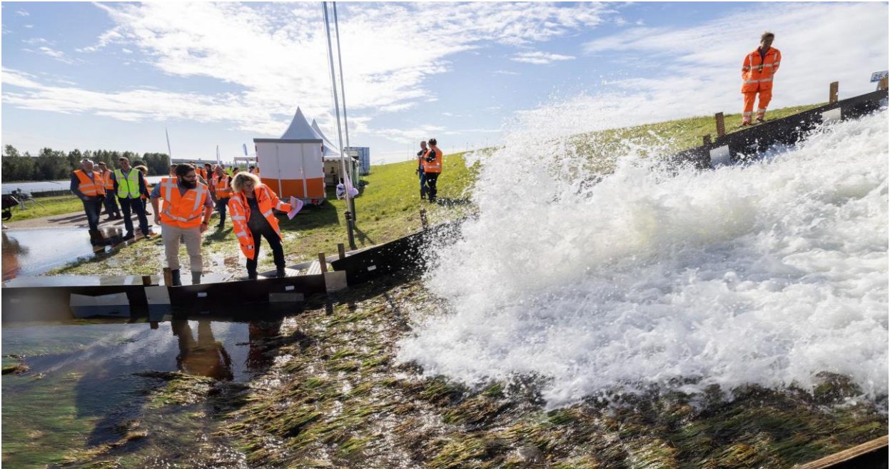
Figuur 4-1: Foto van de overslagproeven bij de IJsselmeerdijk.
